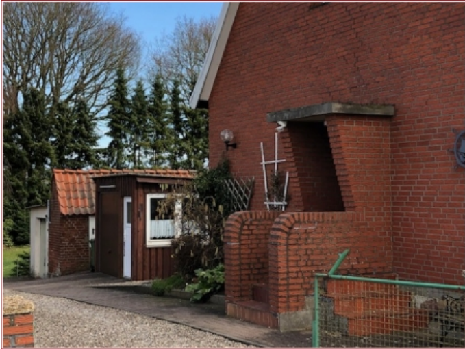
Hauseingang an der Giebelseite links
