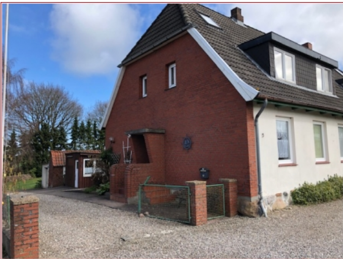
Breite Toreinfahrt zum Hof und zusätzliche Parkmöglichkeiten direkt vor dem Haus
